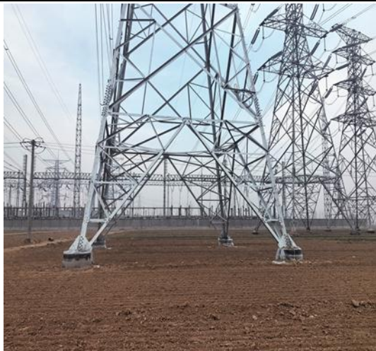
(13) N108 塔基整平及复耕
