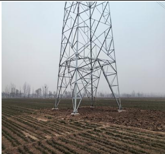
(11) N82 塔基整平
