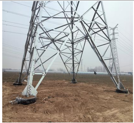
(12) N107 塔基整平
