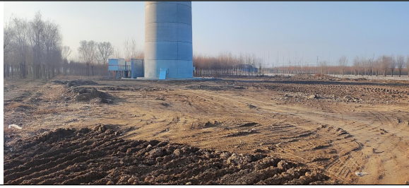
施工结束后对风机周围地面进行平整，施工建筑材料进行了清理
