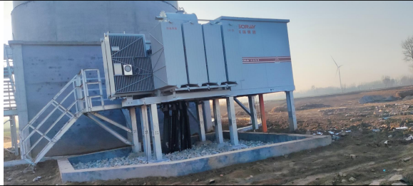
箱式变压器下方设置了贮油坑
