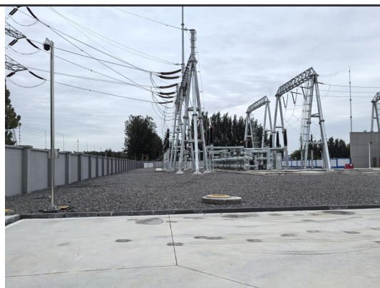
图 4-9 220kV 配电装置
