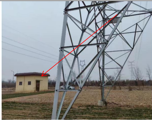
3.董仓村西北侧的水泵房
