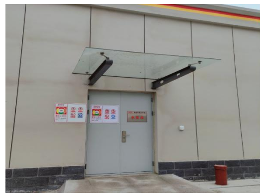
图 4-11 站内水泵房等附属设施
