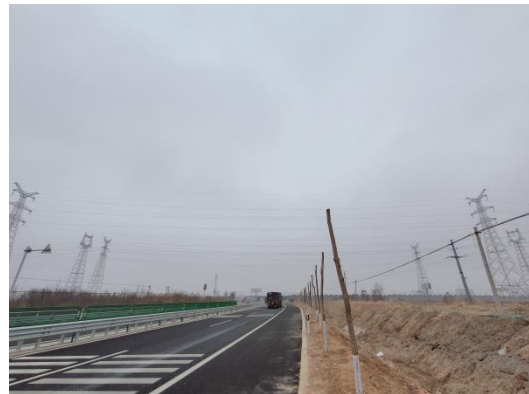
图 4-13 跨越省道 S323 处(26#-27#杆塔)
