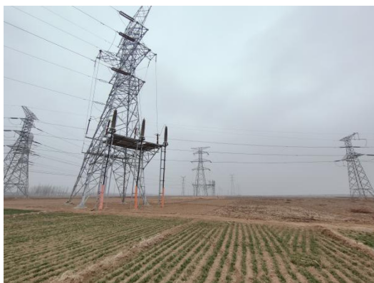
图 4-14 36#~37#单回电缆线路
