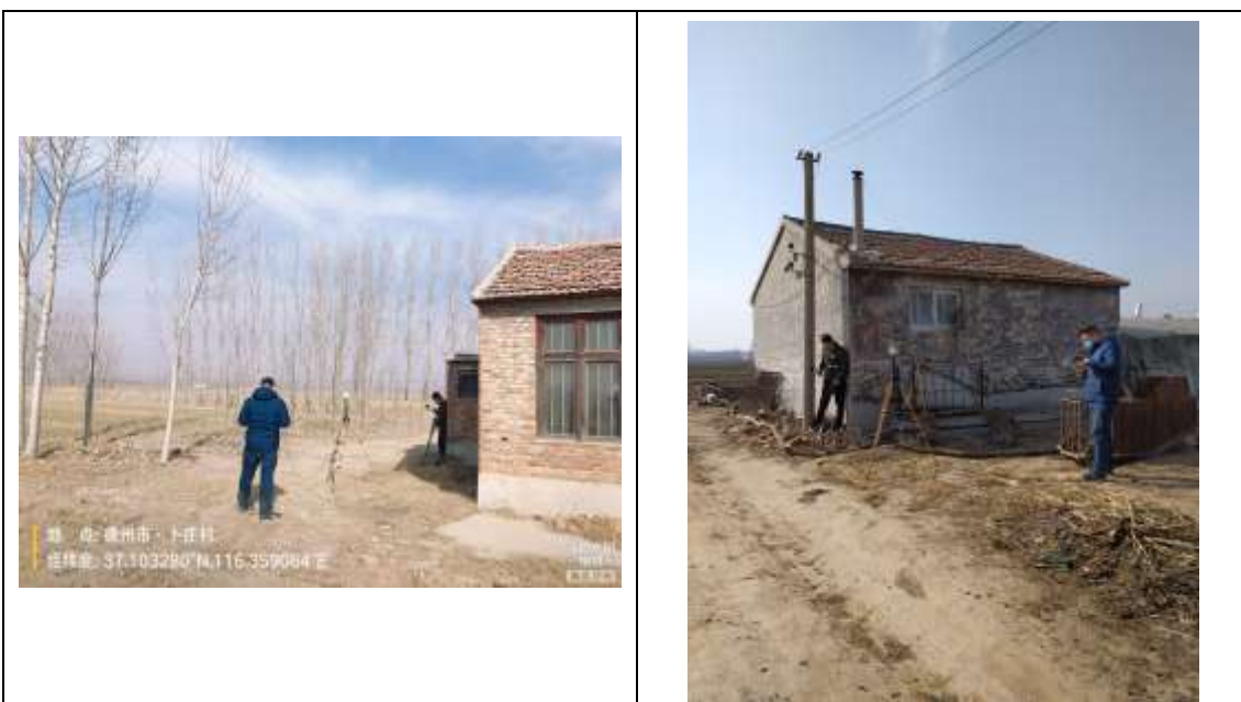
图 2.3 看护房（双回架空线路南侧 30m，卜庄村西侧）
