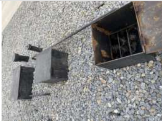
一体化污水处理设施
