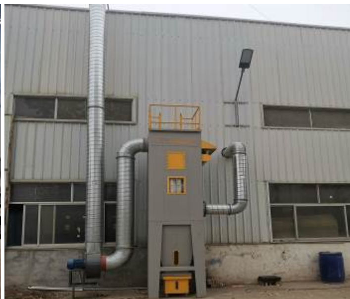
剪板、钻孔废气处理
