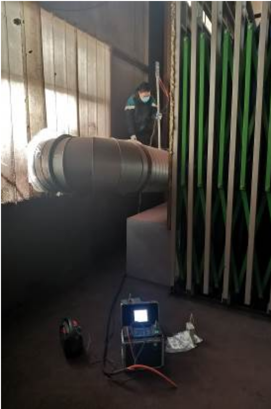
1#排气筒处理设备前监测照片
